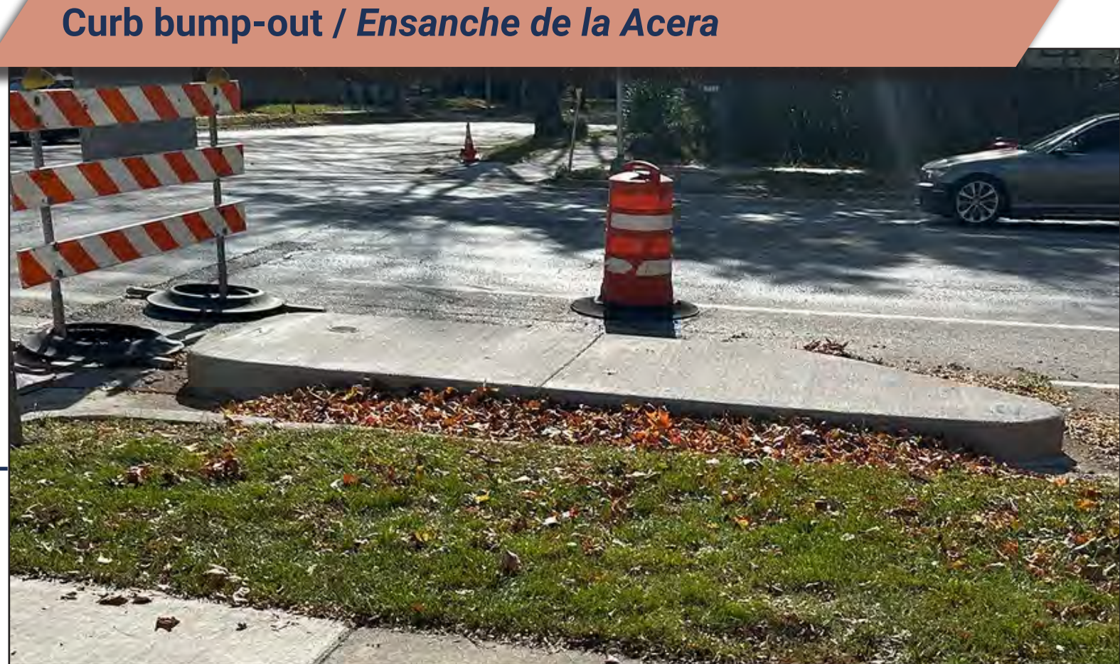
Curb bump-out / Ensanche de la Acera
