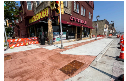
Deposito/Plataforma para autobús en la calle Mineral
