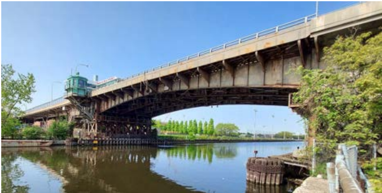
FIGURA 1: Tramo del puente levadizo que existe sobre el río Menomonee. La vista es desde la orilla norte. Junio 2023.
