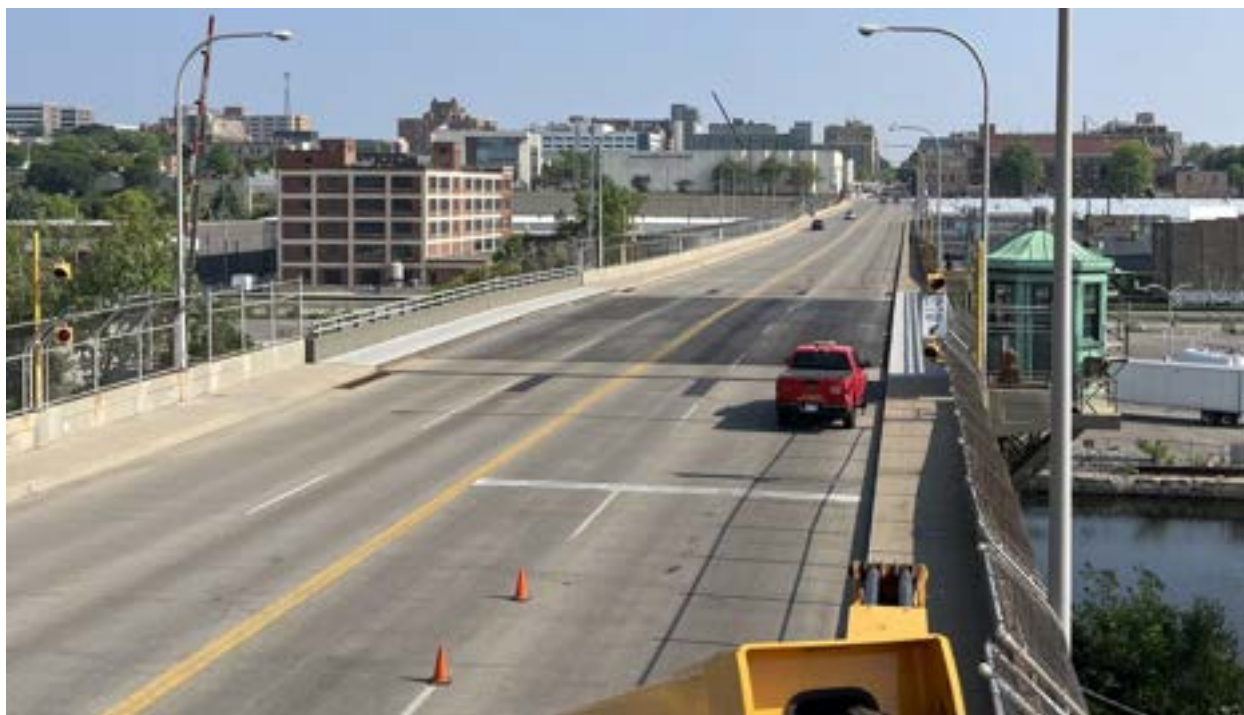
FIGURA 2: Tramo levadizo de la Unidad 14 y rampas de acceso del Viaducto de la Calle 16 hacia el norte. Junio 2023.
